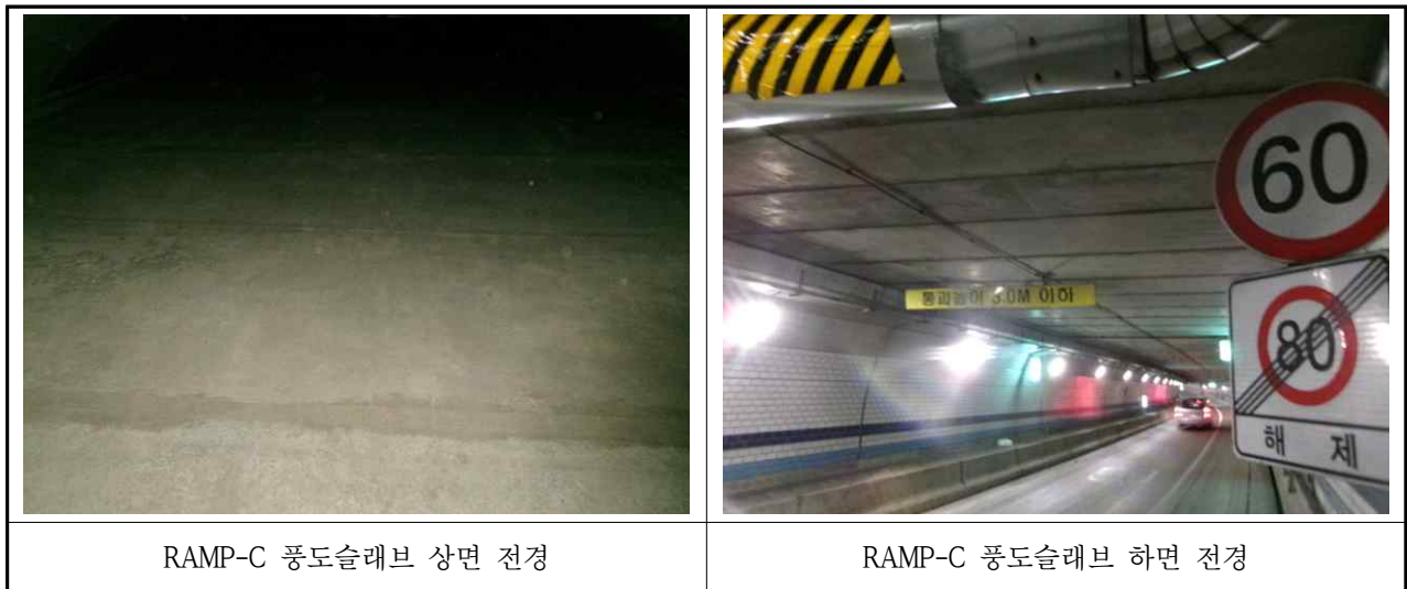
【사진 3.3.27】 NATM구간 풍도슬래브 전경
