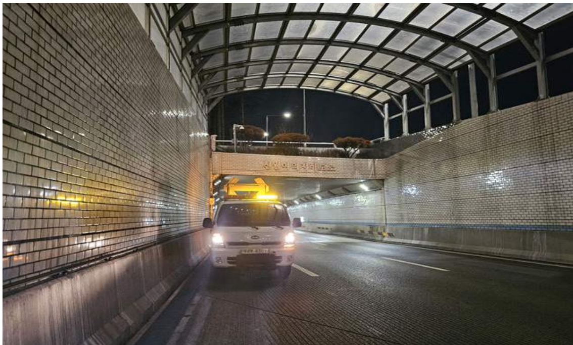
갱문 종점부 전경
