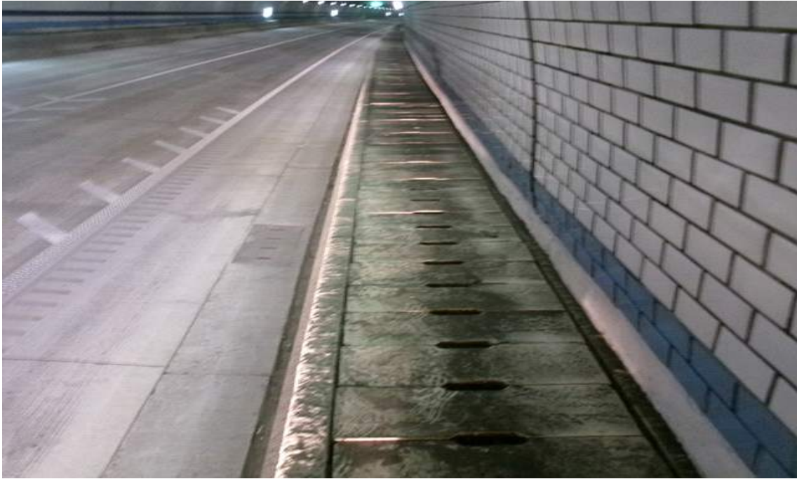
NATM구간 공동구 전경
