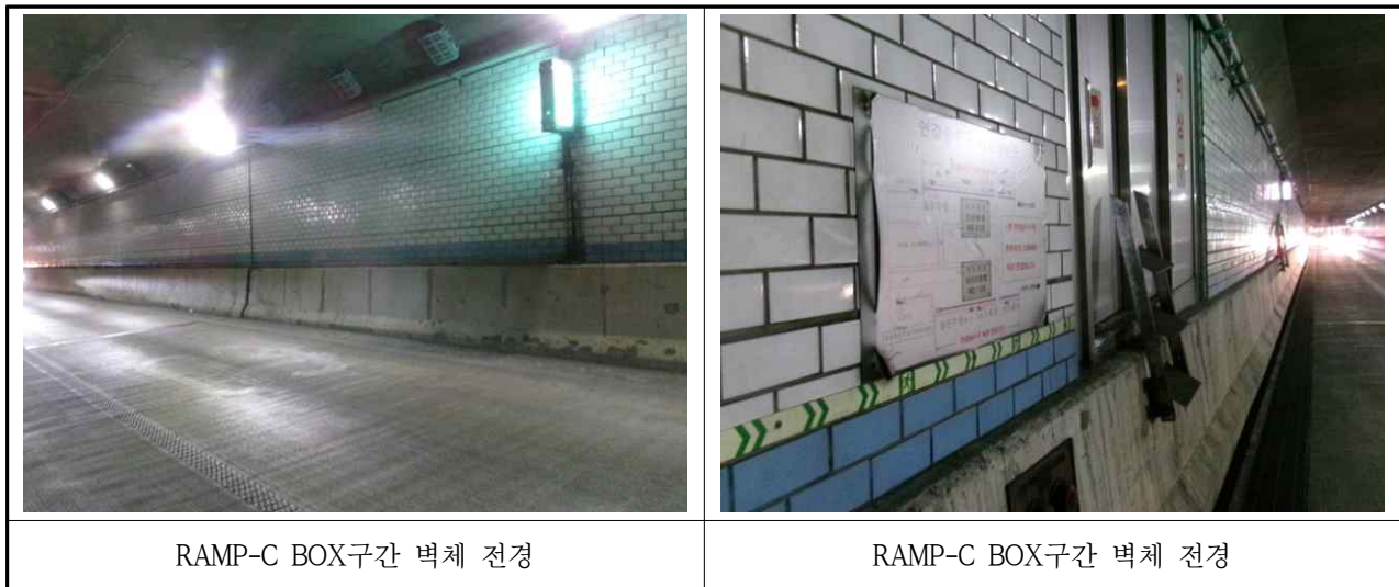
【사진 3.3.21】 BOX구간 벽체 전경
