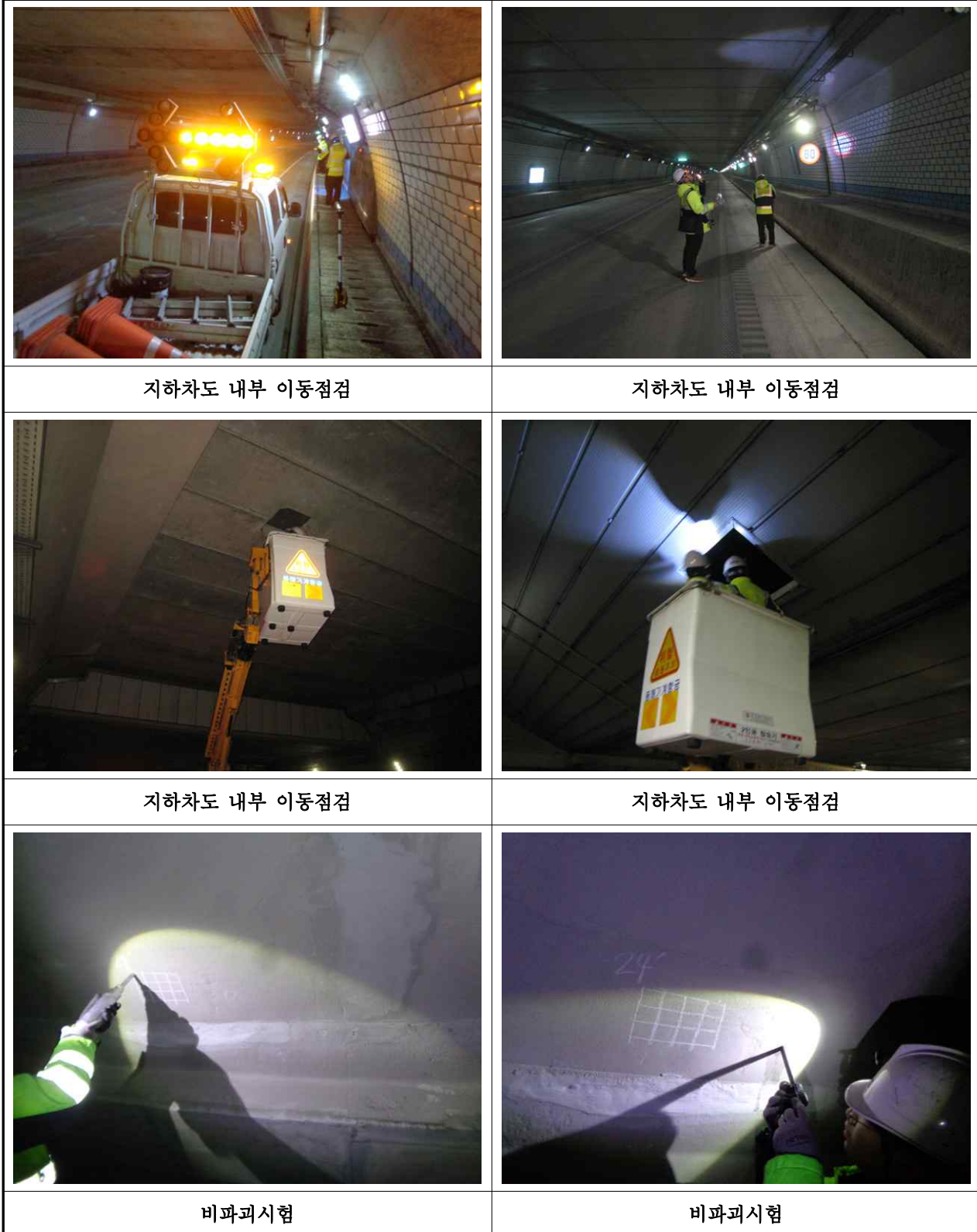
【사진 3.1.1】외관조사 전경
