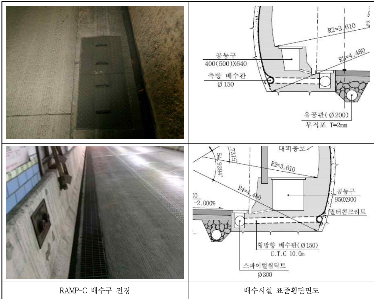
【사진 3.3.33】 배수시설 전경
