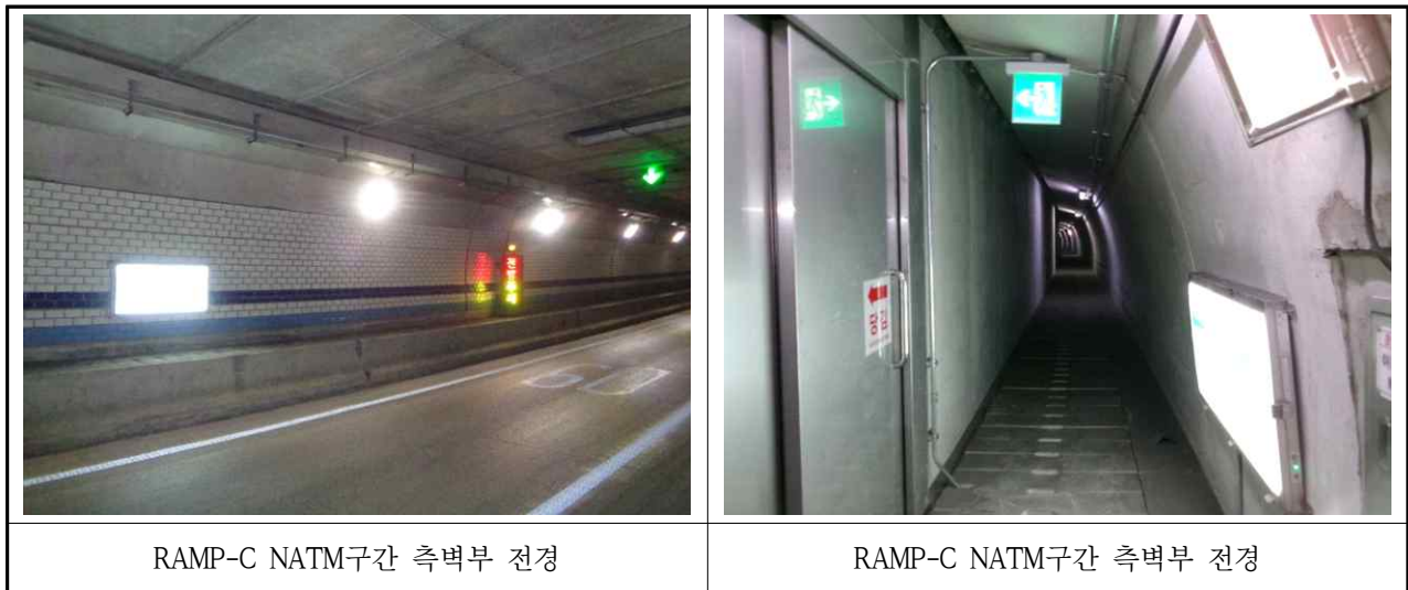
【사진 3.3.25】 NATM구간 측벽부 전경
