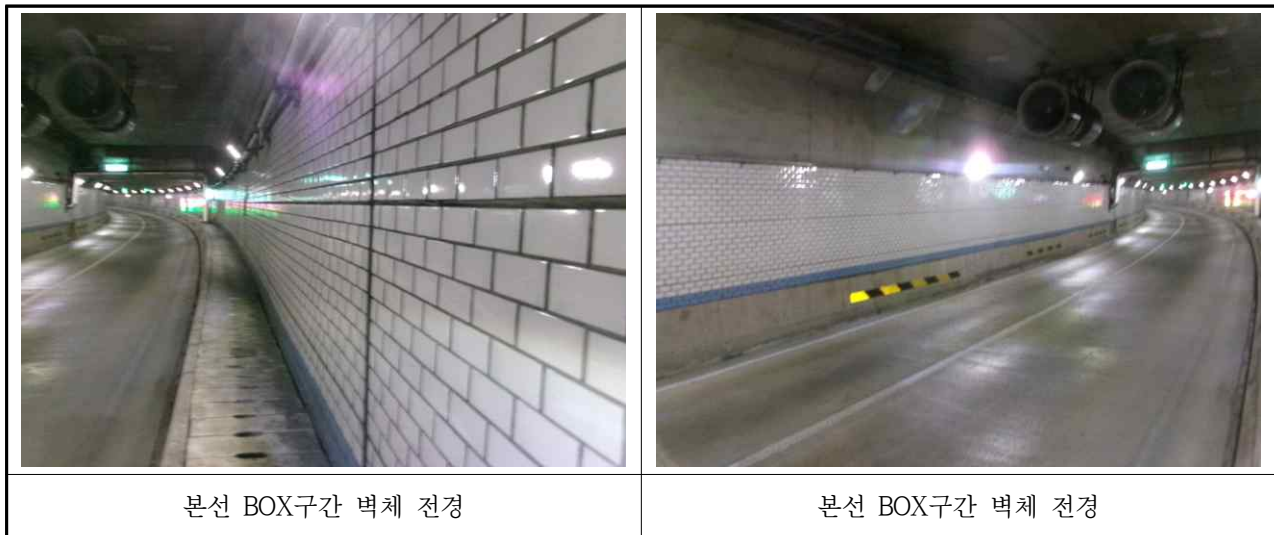
【사진 3.3.3】 BOX구간 벽체 전경
