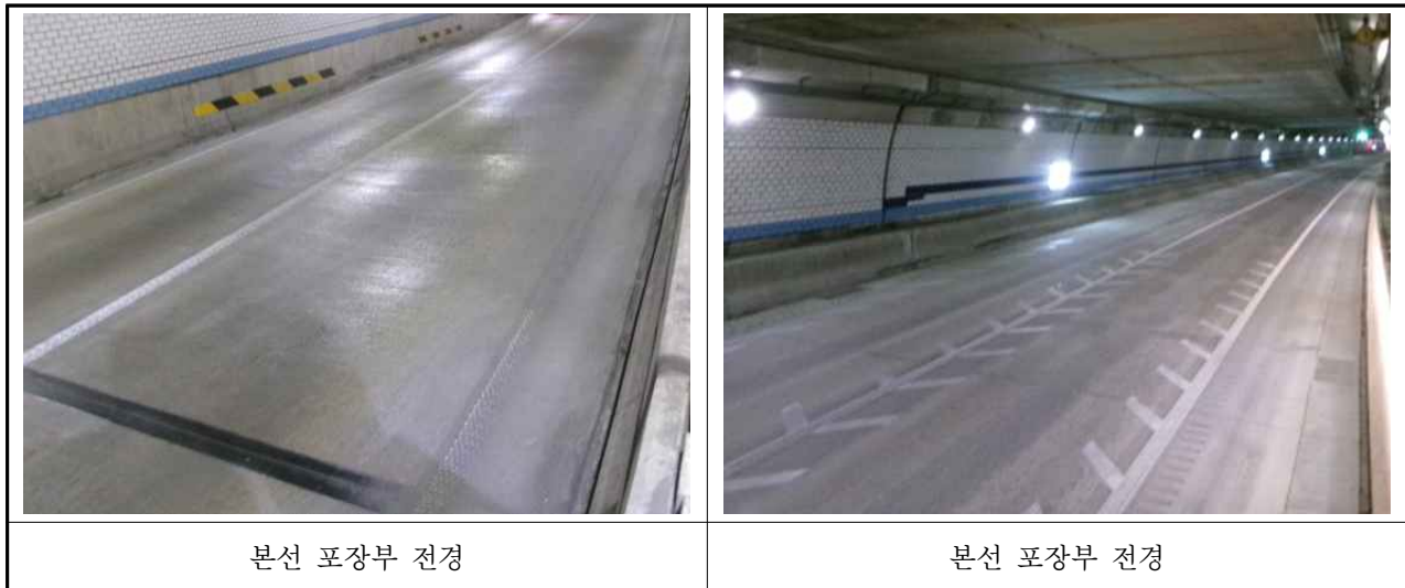
【사진 3.3.11】 포장부 전경
