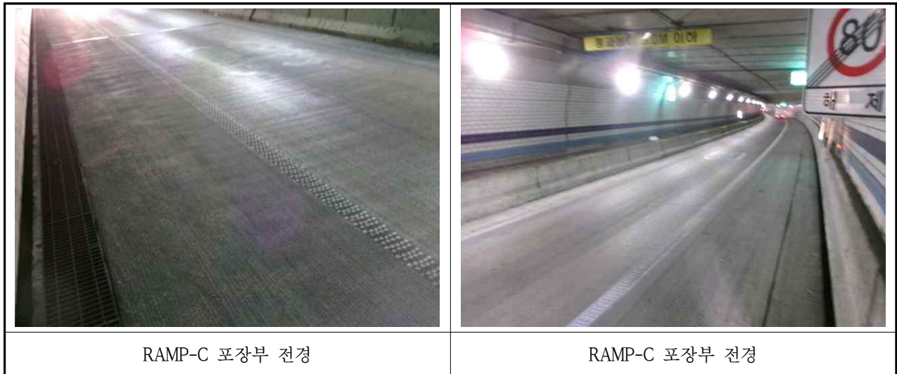
【사진 3.3.29】 포장부 전경
