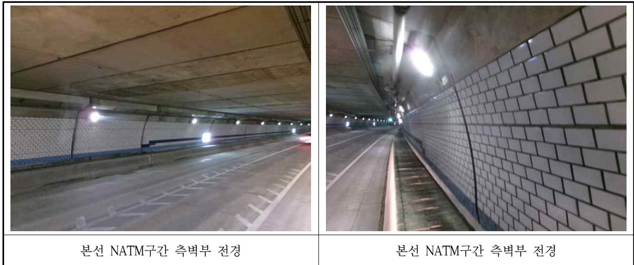
【사진 3.3.7】 NATM구간 측벽부 전경
