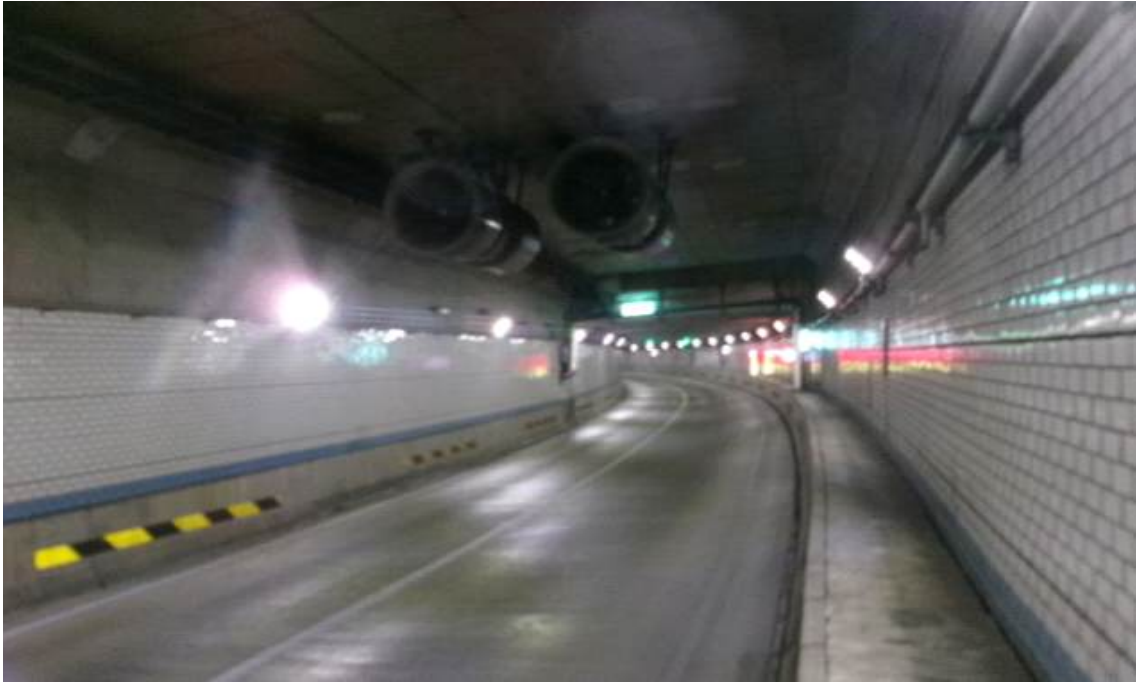
BOX구간 내부 전경
