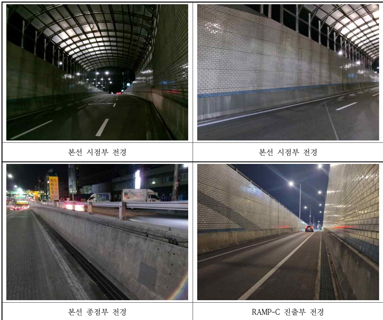
【사진 3.3.41】 U-TYPE 옹벽 전경
